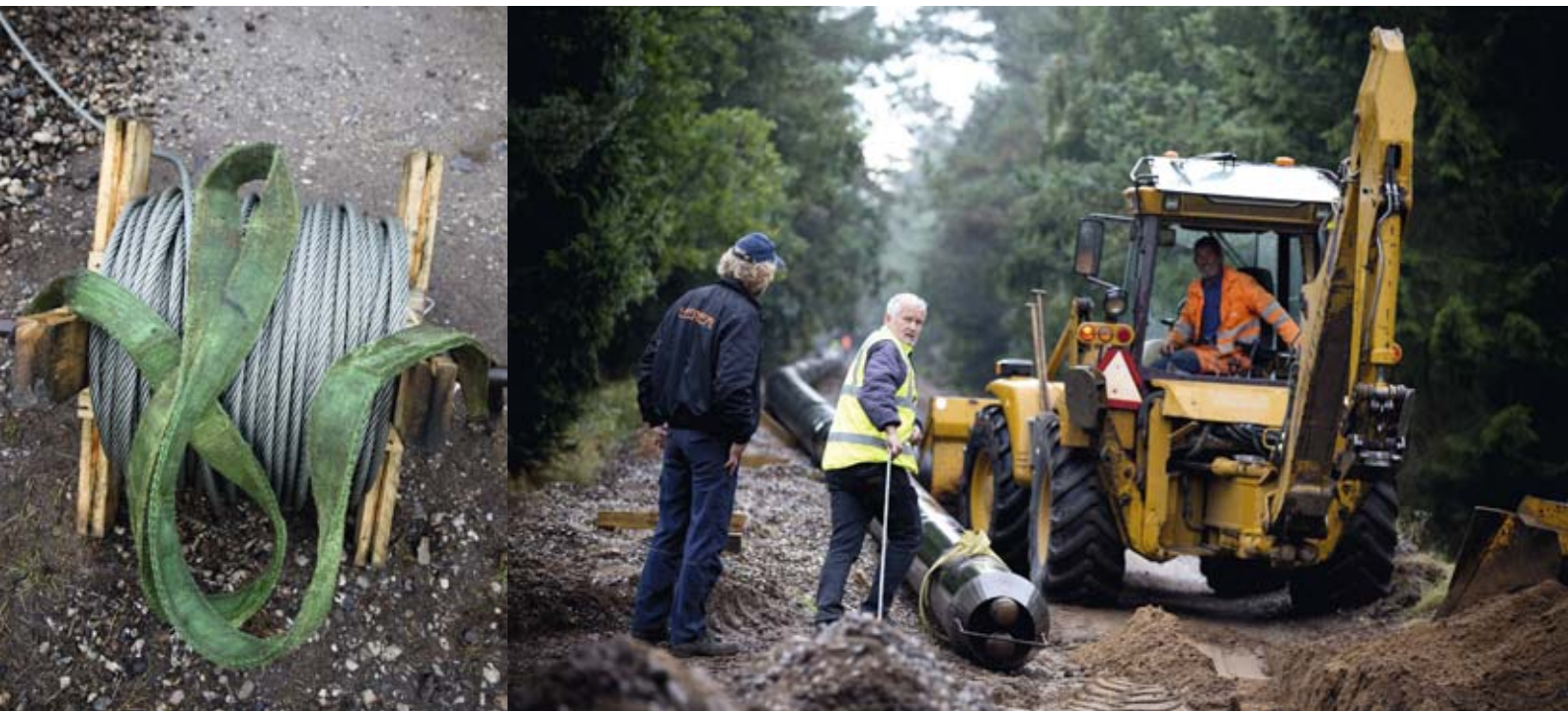
Fjernvarmeledningen mellem Auning og Pindstrup etableres på den gamle banestrækning. Pladsen er knap og derfor svejses røret sammen i sektioner på 200 meter, som efterfølgende trækkes ned i renden.
