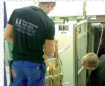
Kontrol af højspændingsbryder
